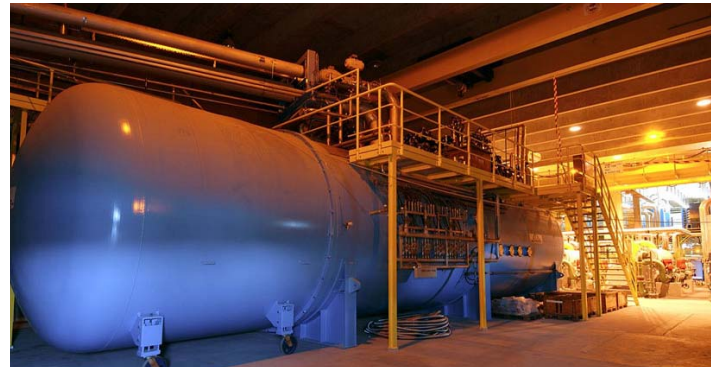
Un refrigerador de helio del LHC.
